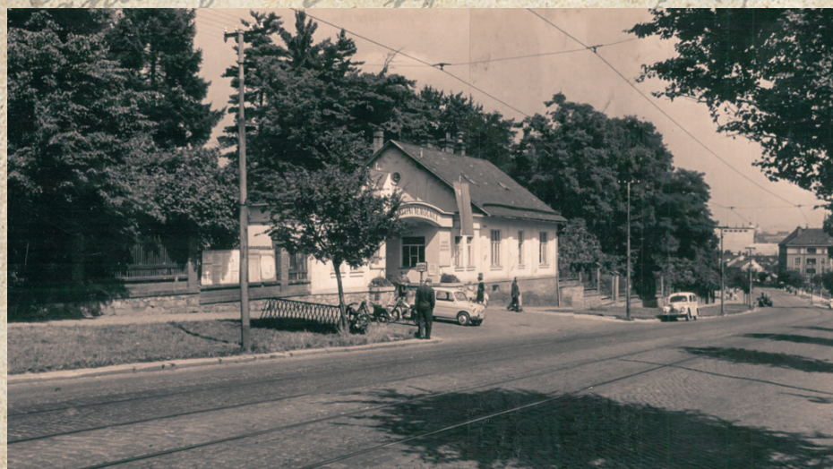
» Stará brána nemocnice stojí dodnes, tramvajové koleje jsou také stále na svém místě, provoz tramvají byl ale zrušen už v roce 1981, trať vedla z Wolkerovy ulice do ulice I. P. Pavlova.
