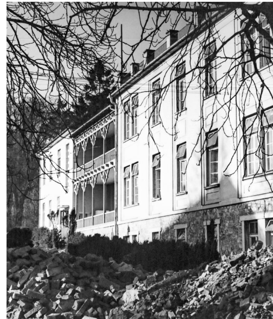
↑ Přední průčelí budovy před rozsáhlými úpravami v letech 1967 – 1970.
